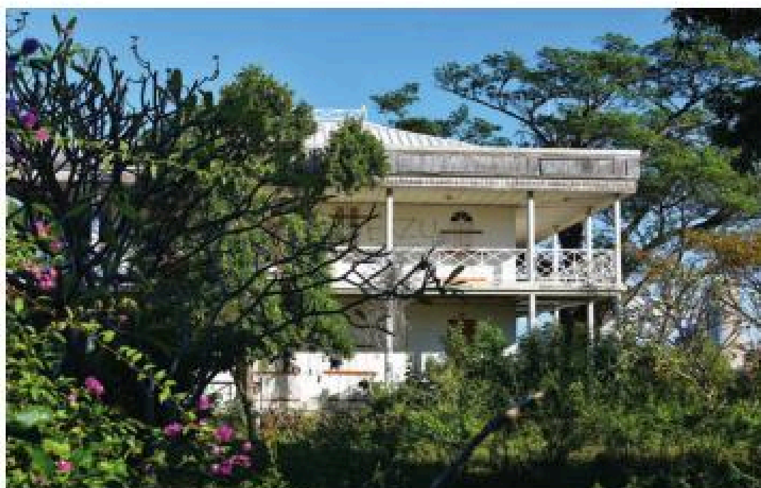
Maison des Ingénieurs au Port.
