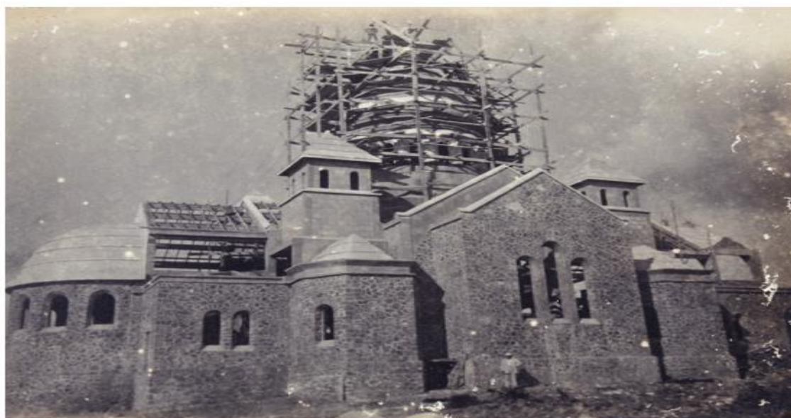
La coupole en cours d'achèvement
