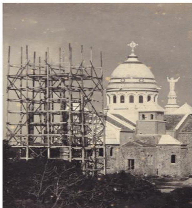
Le clocher en cours de construction, 1924
